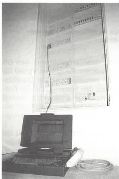
Umprogrammieren der Komponenten ist direkt am Verteiler möglich.
