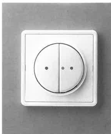
Tastsensoren – hier in Zweifachausführung – werden einfach nur auf die Ankopplung aufgesetzt.
